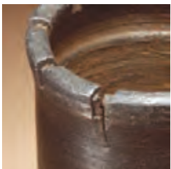
FISSURES DANS LES SEGMENTS
