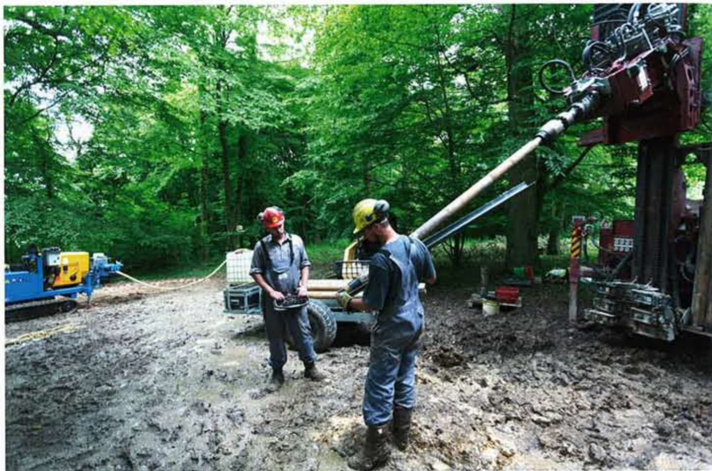
Utilisée en carottage, les machines de forage sonique traversent les sols les plus hétérogènes quatre à cinq fois plus vite.
